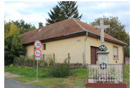
fent: a 233/1-es helyrajzi számú ház tömegformálása jó példa erre a típusra, a homlokzat a funkcióváltás miatt módosult
